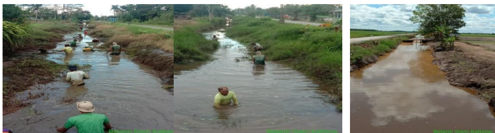
Gambar 18. Pembersihan saluran tersier
