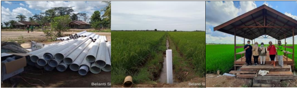
Gambar 19. Perbaikan pintu-pintu saluran dan pembenahan prasarana lainnya
